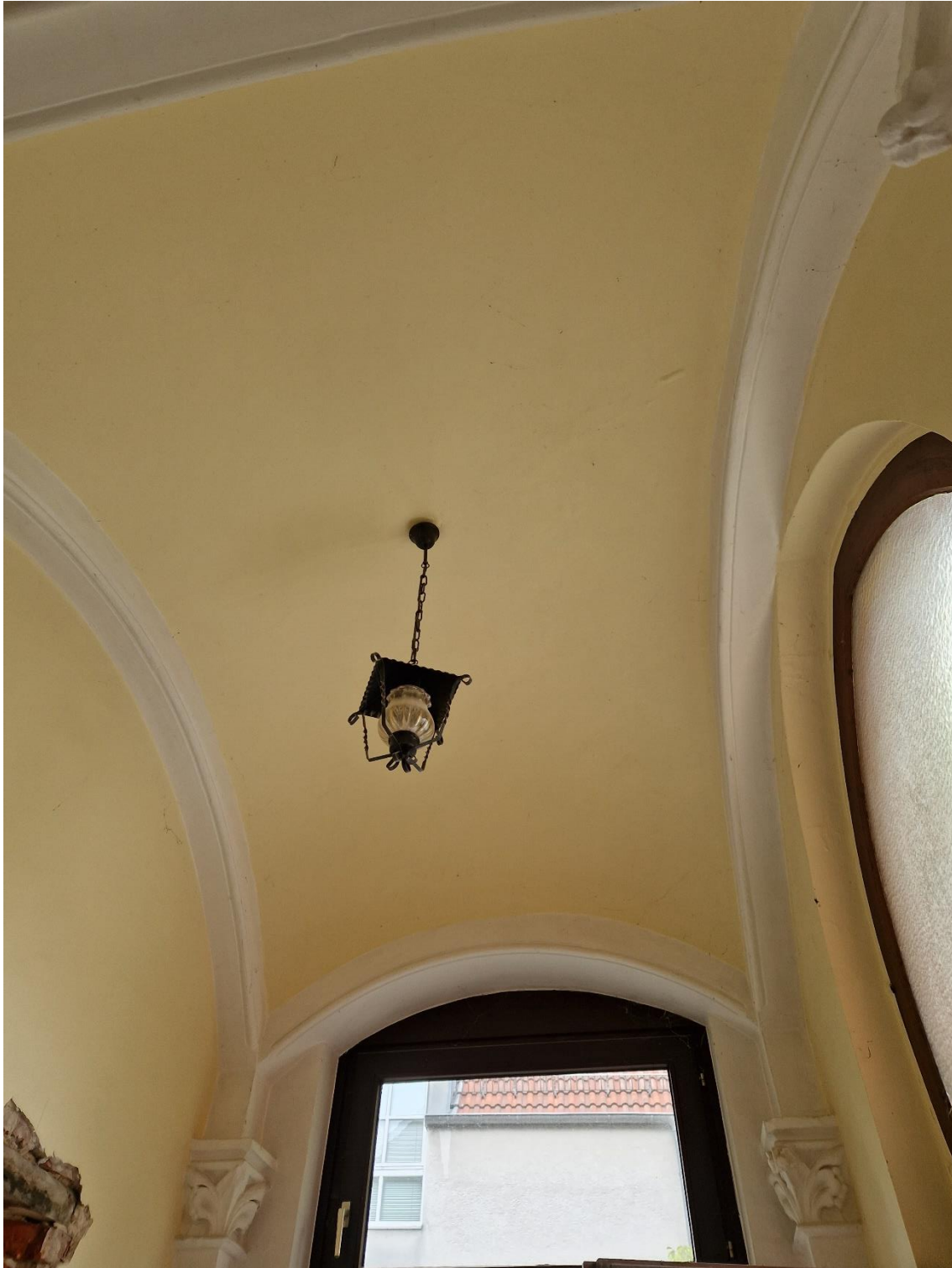
Abb. 8: Flur – Eingangsbereich. Der Eingang bleibt bei der Umgestaltung in den 1950er Jahren unversehrt und wurde lediglich bei diversen Renovierungen neu gefasst. Hier ist noch der bauzeitliche Wandanschluss mit den Kapitellen erhalten geblieben. In die Überlegung zur Rekonstruktion der originalen Decke im Flur und Vorhalle sollte dieser Bereich mit einbezogen werden.
