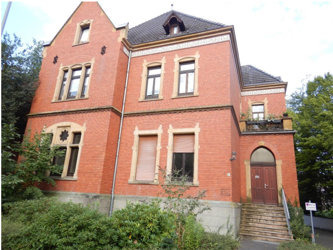
Abb. 1: Haus Unter den Ulmen 6 – Vorderansicht von der Straße aus, August 2023.
