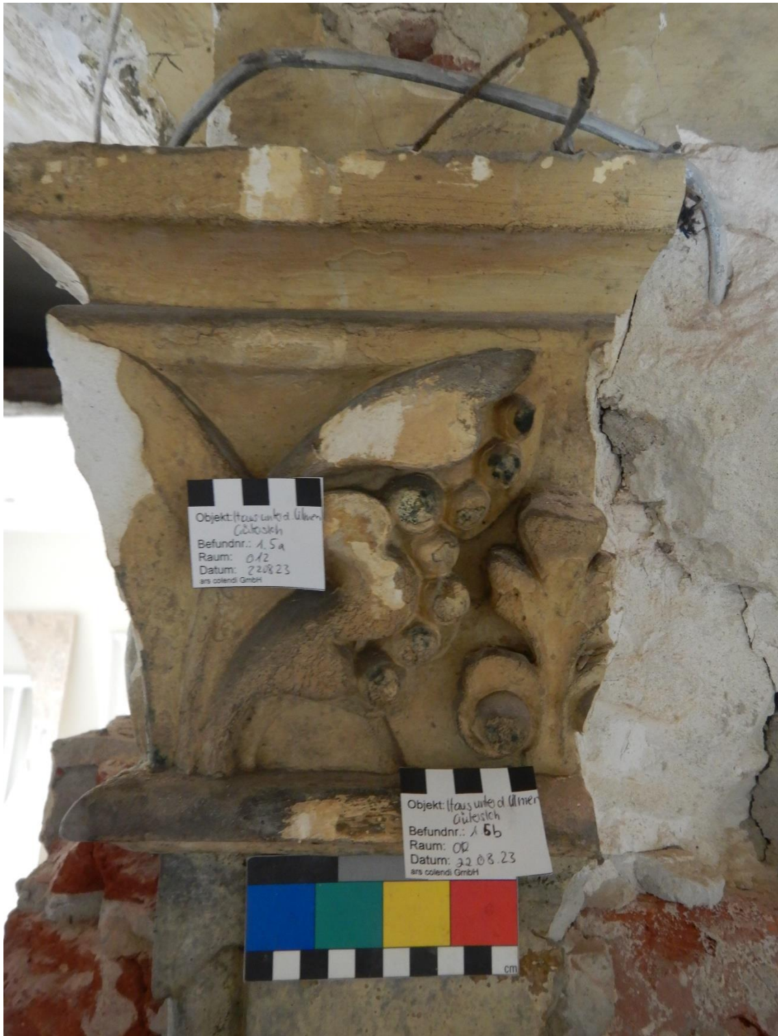
Abb. 17: Vorhalle – Eines der bauzeitlichen, noch erhalten gebliebenen Kapitelle mit den Befundstellen 1.5.a und 1.5.b. Leider wurde dieses wie auch das zweite Kapitell bei den Umbauten in den 1950er Jahren stark beschädigt.
