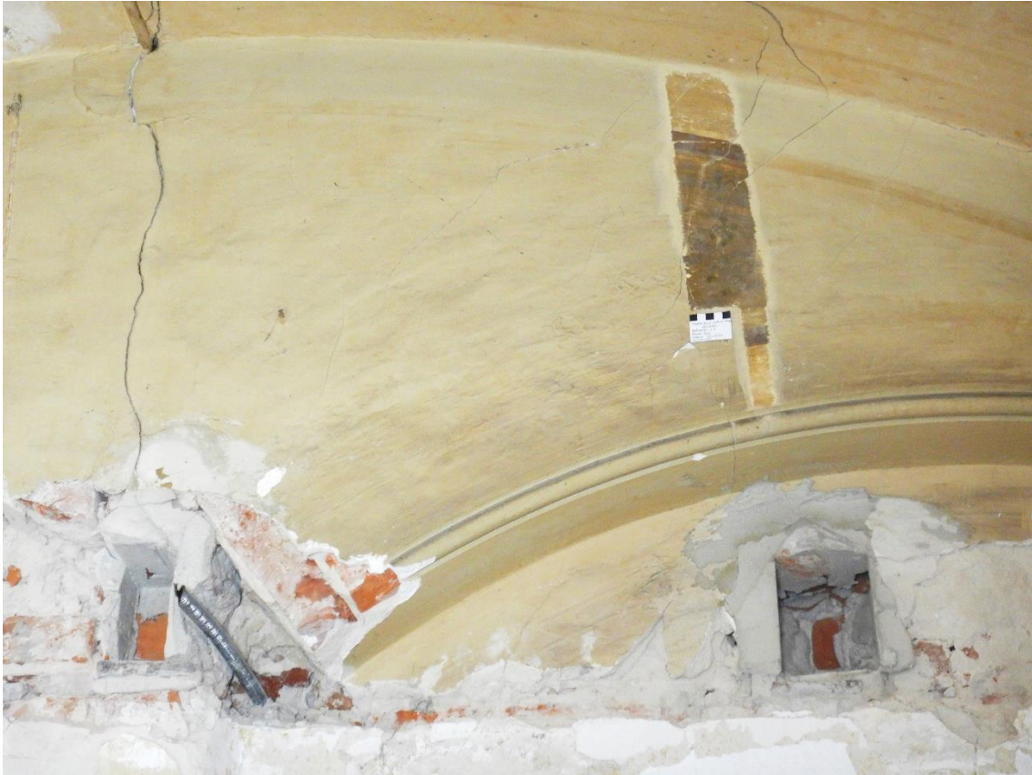
Abb. 12: Vorhalle – Schablonenmalerei mit Lilien und Kreuzblumen auf den Bogenfläche der Wandbereiche.
