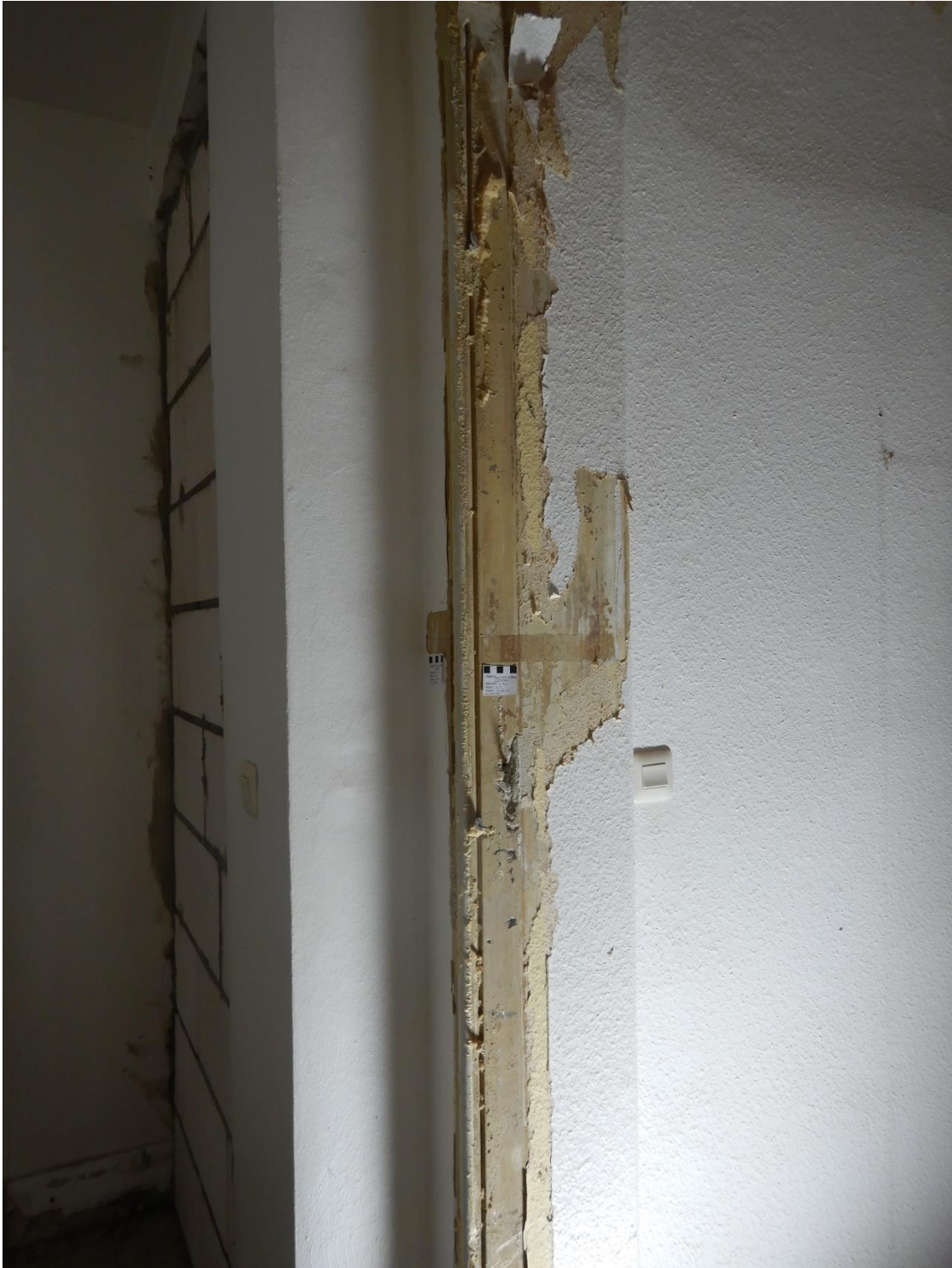
Abb. 16: Vorhalle – Die bauzeitlichen Pilaster mit Kapitellen wurden bei der Deckenabhängung in den 1950er Jahren entfernt oder wie in dieser Abbildung in die spätere Wandgestaltung mit Raufasertapete eingebunden.
