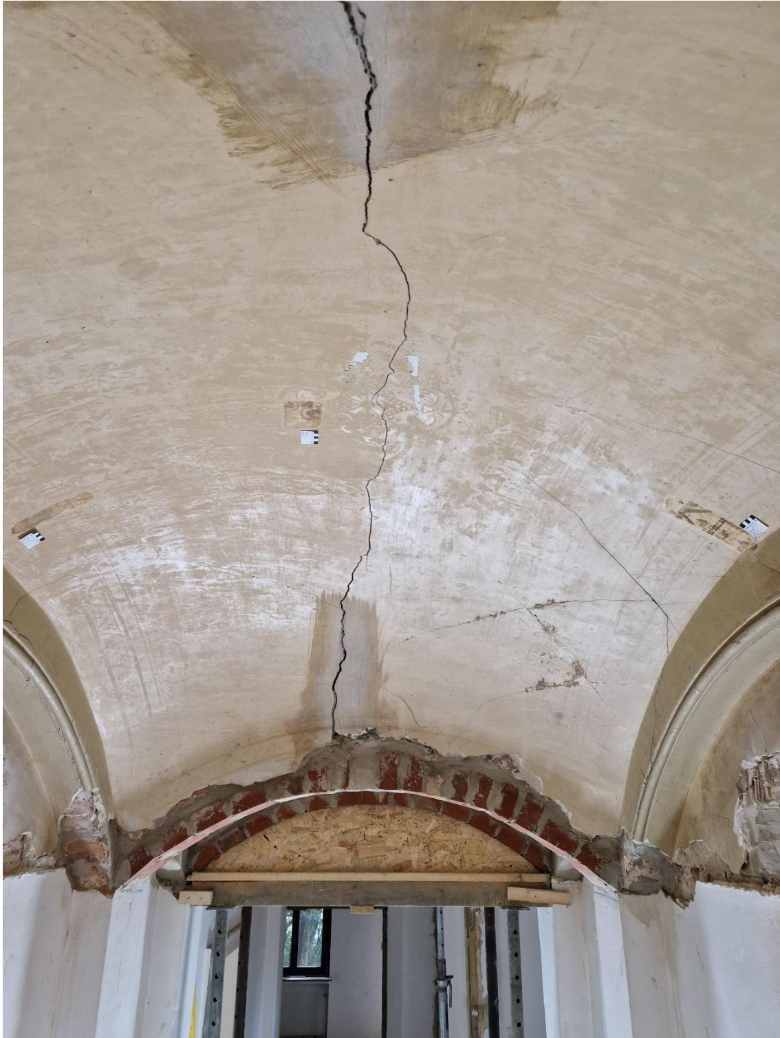
Abb. 19: Flur – Vorzustand August 2023. Sichtbar der aufgebraachte leicht glänzende Tiefengrund zur Vorbereitung einer Neugestaltung, die jedoch nicht ausgeführt wurde.
