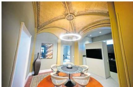
Das besondere Kreuzgewölbe haben die Experten hinter der abgehängten Decke im Flur-Bereich entdeckt.
