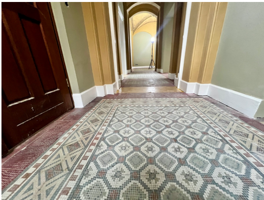
Der historische Fußboden wurde im Zuge der Restaurierung der Villa komplett aufgearbeitet.
