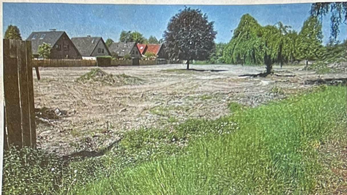
Abgeschoben, freigeräumt: Das Baugebiet wird seit einiger Zeit vorbereitet.
