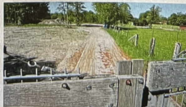
Anderes Grundstück: Am Ende dieses Weges haben Arbeiten begonnen, einen illegal zugekippten Teich wieder auszukoffern.
