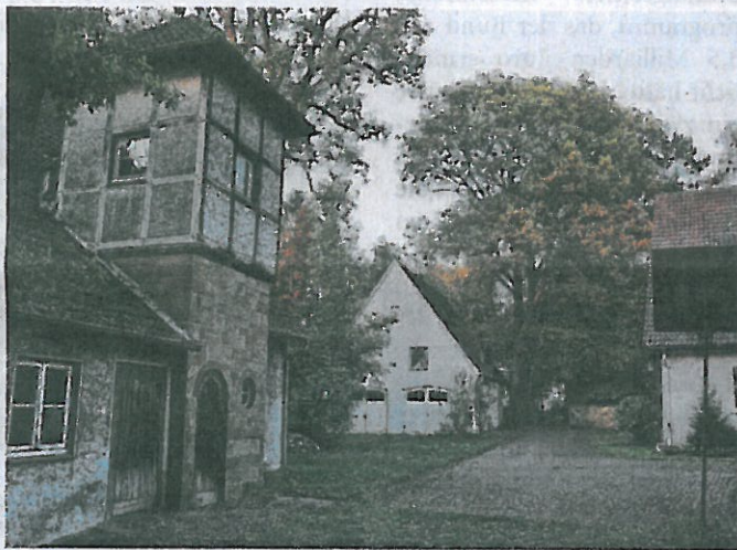
Wirtschaftsgebäude: Während der Turm erhalten bleibt, soll das weiße Haus in der Mitte abgerissen werden.
